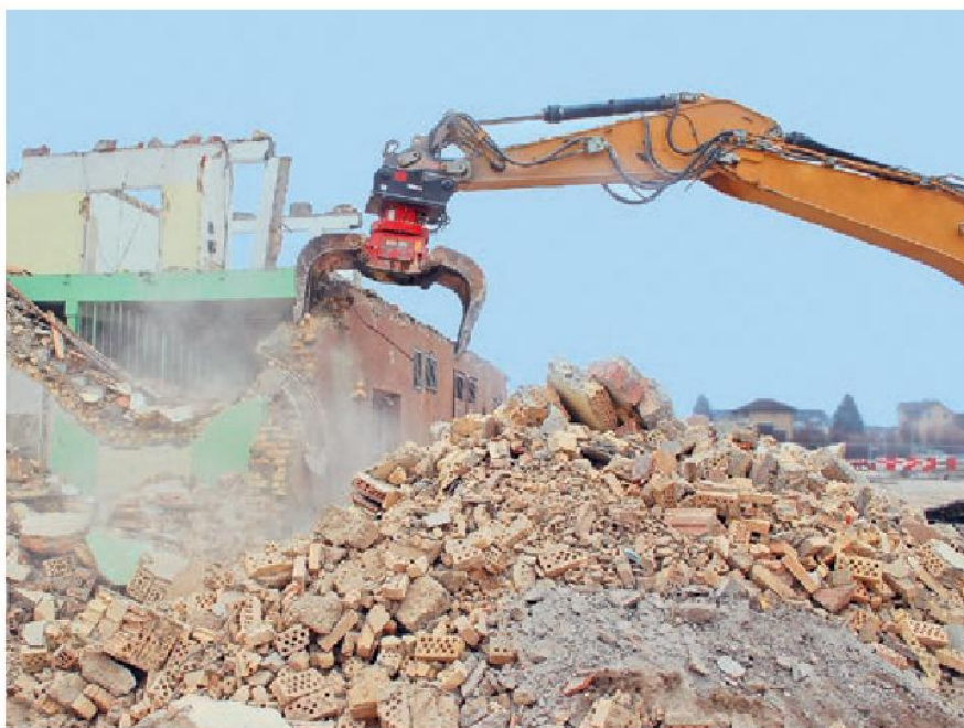
Die Zeiten der Abrissbirne sind vorbei – Aus Abbruch wurde Rückbau.
