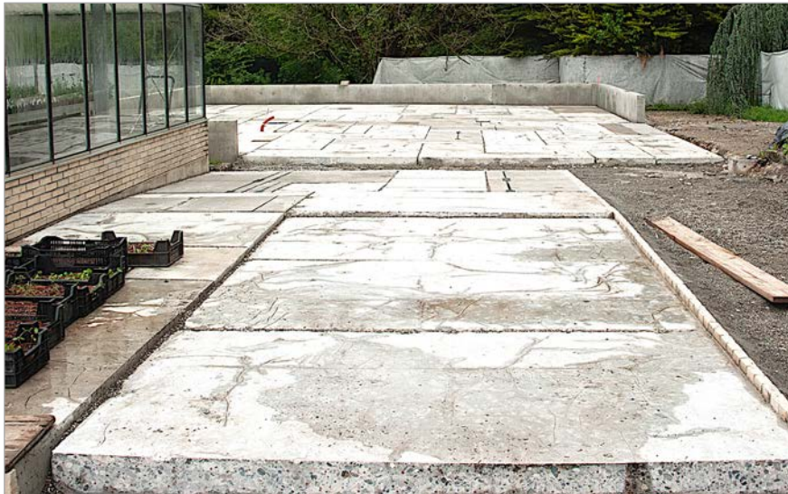
FAZ Architectes Dalles pour parking (Meyrin, CH, 2021)
