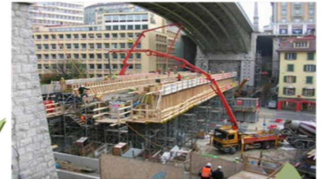
Construction d'un ouvrage en béton
