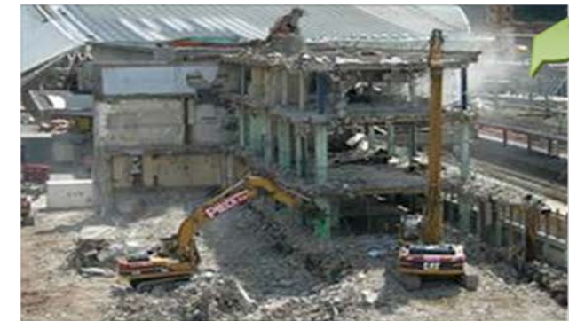
Déconstruction d'un bâtiment.
