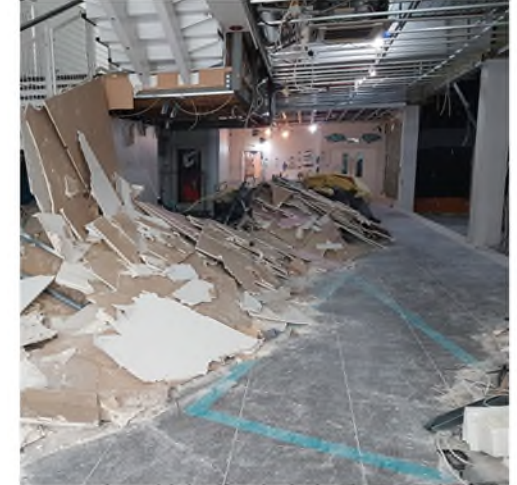
Strip-out: rimozione pannelli di cartongesso (partizioni interne verticali e orizzontali).
