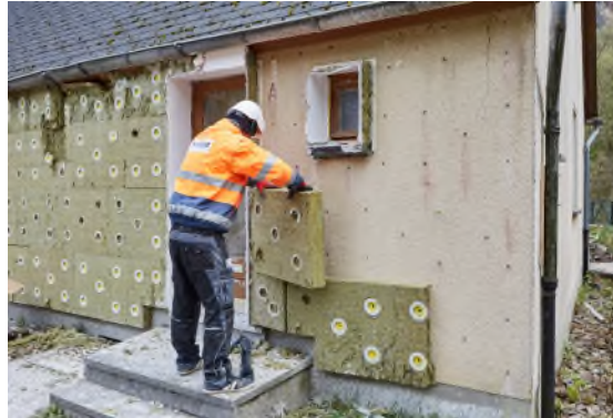
Quelle: Saint-Gobain Weber: Recyclingfähiges Wärmedämmverbundsystem, in Detail selection: Recycling: Materialien, Systeme, Konzepte, 2020.
