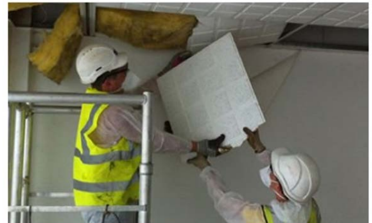
Strip-out: rimozione lastre controsoffitto contenente amianto.
