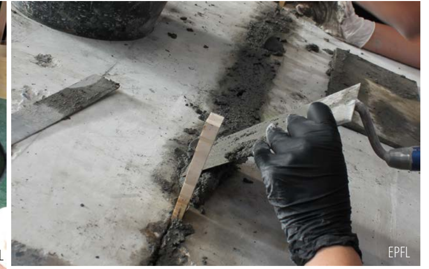
ajout de matériaux
