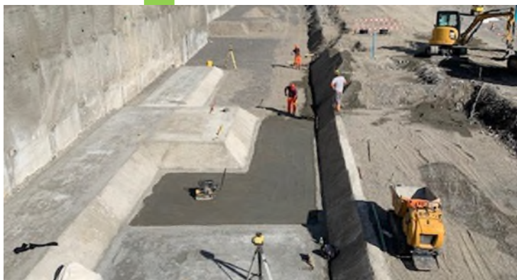
Mise en œuvre produit revalorisé
