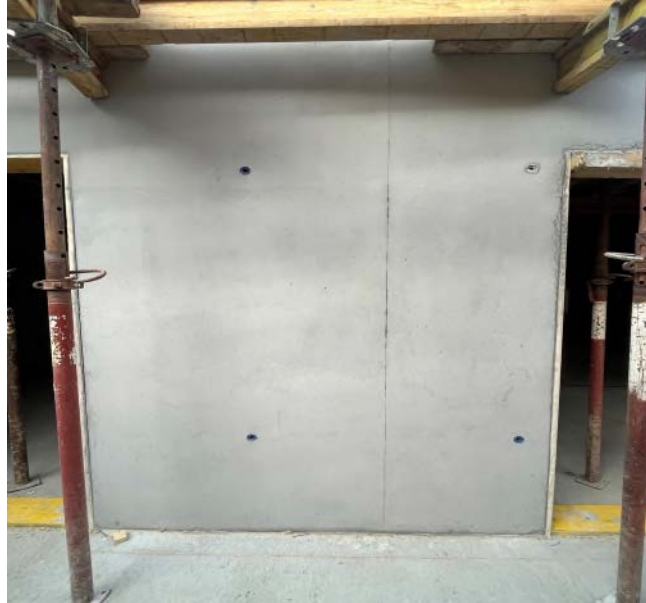
E44326 Sorte C RC-C25 C30/37 XC4 22 Cl.0,20 C3 E30 Étalement 500 mm (F4)
