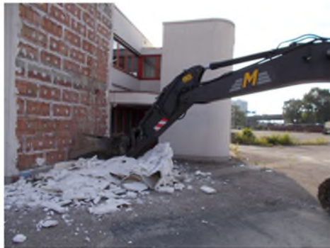
Fig. 4. Rimozione isolamento esterno di facciata con metodo parzialmente selettivo.
