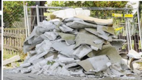
Fig. 5. Isolamento esterno di facciata rimosso con metodo parzialmente selettivo.
