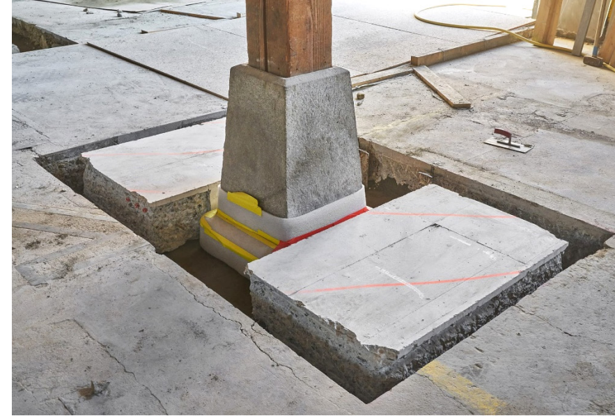
Baubüro in situ Fondation pour colonnes (Zürich, CH, 2022)
