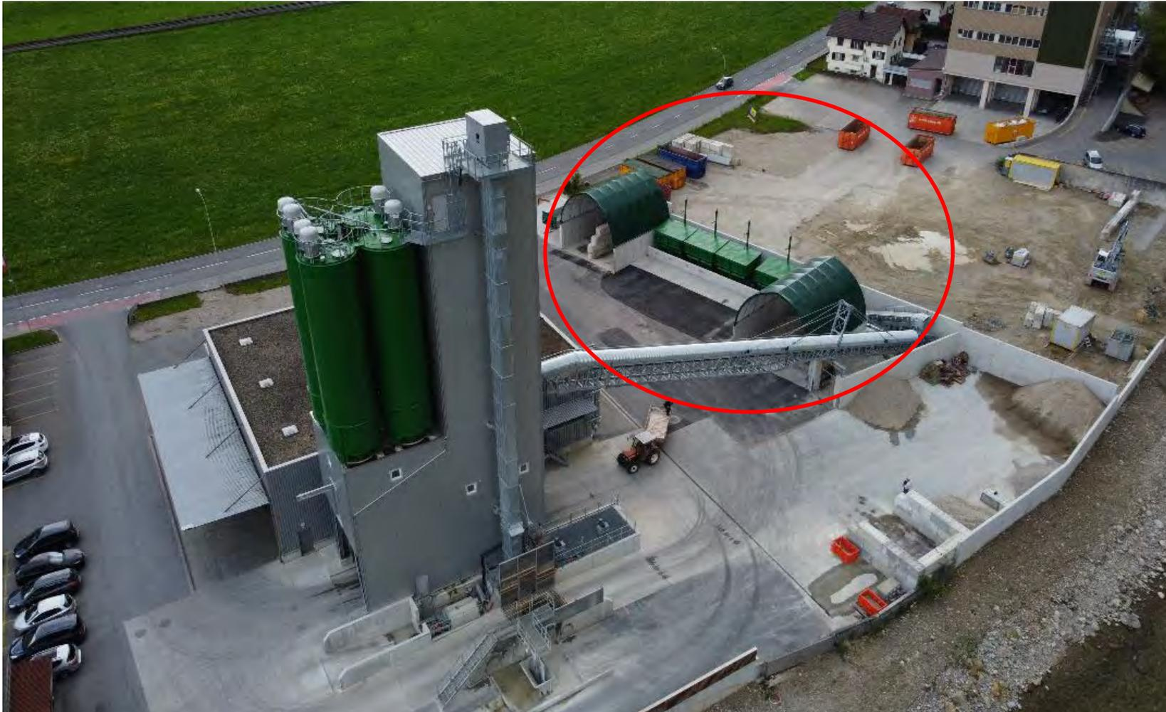
Beispiel einer Integration von 4 speziellen Recycling Doseuren in eine Turmanlage.
